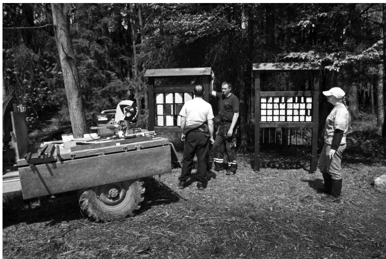
Dokončování NS v údolí Vošmendy na jaře 2015
